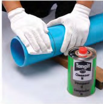
5. ใช้หน้ำยาทำความสะอาดท่อพีวีซี “ตราช้าง” ทำความสะอาดปลายท่อที่จะสวมใส่และบริเวณแหวนรองแหวนยาง
