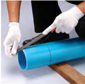
4. ใช้ตะไบละเอียดแต่งรอยตัดให้เรียบและลบมุมปลายท่อโดยรอบ มีความลาดเอียงประมาณ 15 องศา
