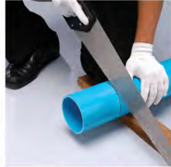
3. ตัดท่อด้วยเลื่อยช่างไม้ หรือ เลื่อยตัดโลหะ หรือ Tubing Cutting
