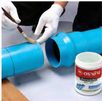
7. ทาหน้ำยาหล่อลื่น “ตราช้าง” (Pipe Lube) บริเวณปลายท่อ และด้านในหัวต่อ
